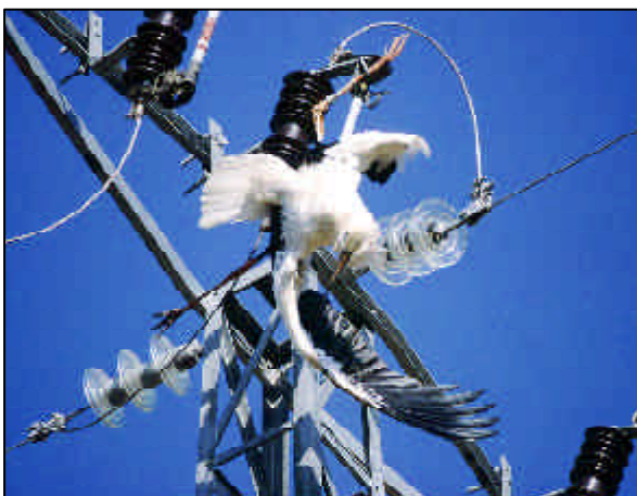
Abb.5: Stromtod-Opfer an Mittelspannungsmasten in verschiedenen Regionen Spaniens. Als besonders gefährlich erwiesen sich Masten mit waagrecht abge-spannten Isolatoren. Das Bild unten rechts zeigt allerdings einen der „theore-tisch“ ungefährlichen Masten mit Hängeisolatoren. An diesem Mast verun-glückte am 26.08.2001 in Südspanien der Senderstorch Pfäffi
