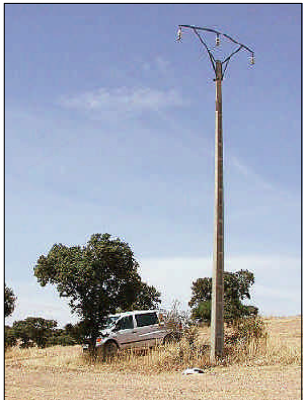
Abb.5: Stromtod-Opfer an Mittelspannungsmasten in verschiedenen Regionen Spaniens. Als besonders gefährlich erwiesen sich Masten mit waagrecht abge-spannten Isolatoren. Das Bild unten rechts zeigt allerdings einen der „theore-tisch“ ungefährlichen Masten mit Hängeisolatoren. An diesem Mast verun-glückte am 26.08.2001 in Südspanien der Senderstorch Pfäffi
